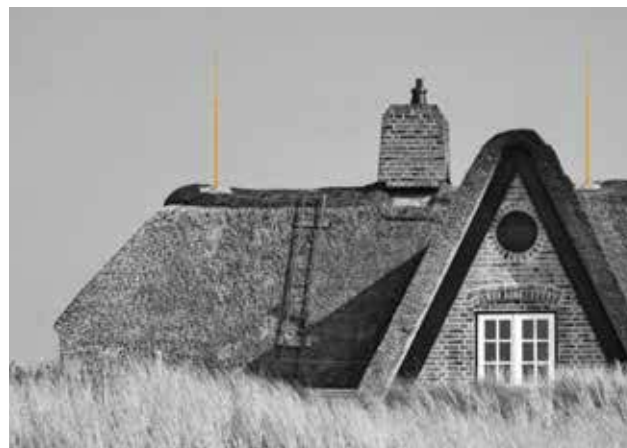
Рис. 2.71: Крыша с мягким покрытием с проводом isCon®
