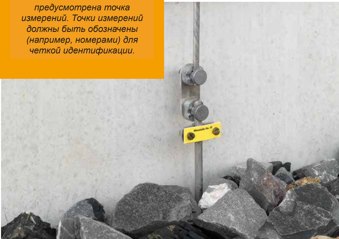
Рис. 2.48: Точка измерения на вводе в землю
