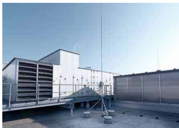
Рис. 2.22: Изолированная молниезащита с молниеприемной мачтой isFang
