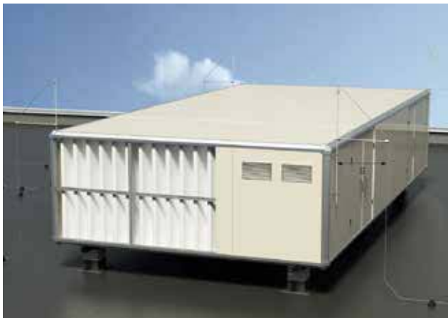
Рис. 2.28: Изолированный молниеприемник с разделительным интервалом (s)
