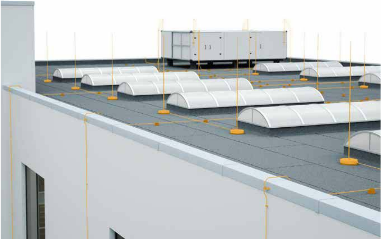
Рис. 2.14: Естественные компоненты (здесь: жестяной аттик) для молниеприемников, VDE 0185-305-3 (IEC 62305-3)
