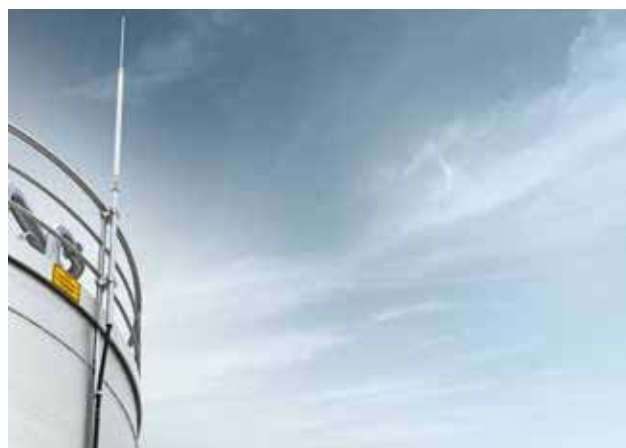
Рис. 2.58: Разделенная молниезащита с проводом isCon®
