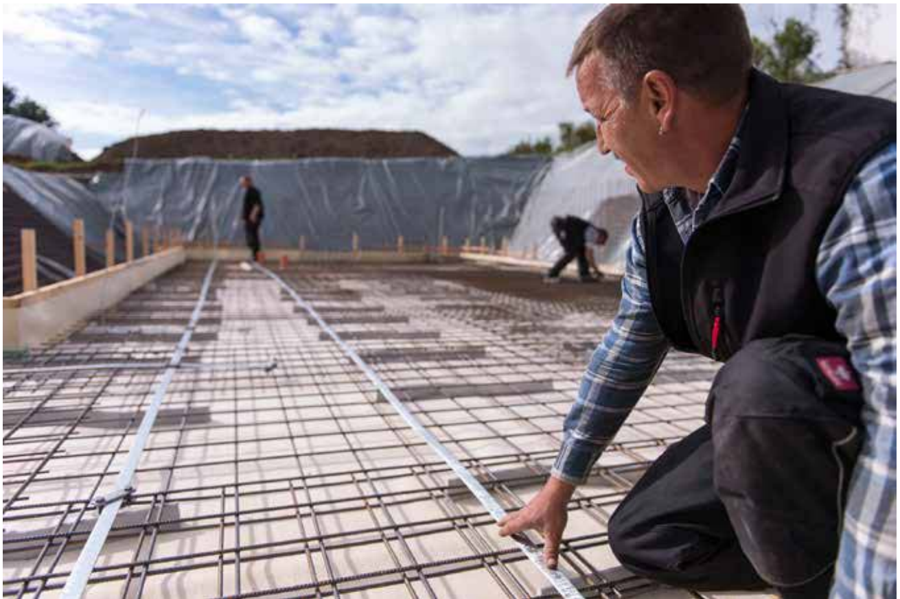
Рис. 2.75: Прокладка фундаментного заземлителя
