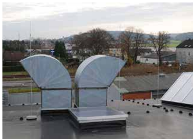
Рис. 2.24: Разделенная система со стеклопластиковыми держателями
