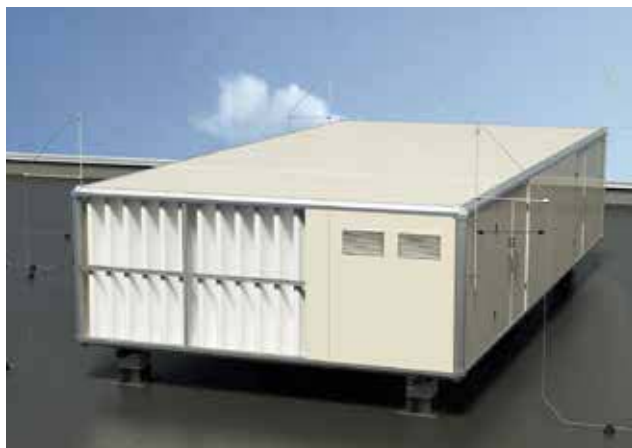
Рис. 2.28: Изолированный молниеприемник с разделительным интервалом (s)
