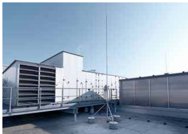
Рис. 2.22: Изолированная молниезащита с молниеприемной мачтой isFang
