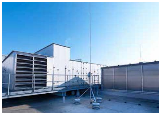
Рис. 2.29: Алюминиевая молниеприемная мачта
