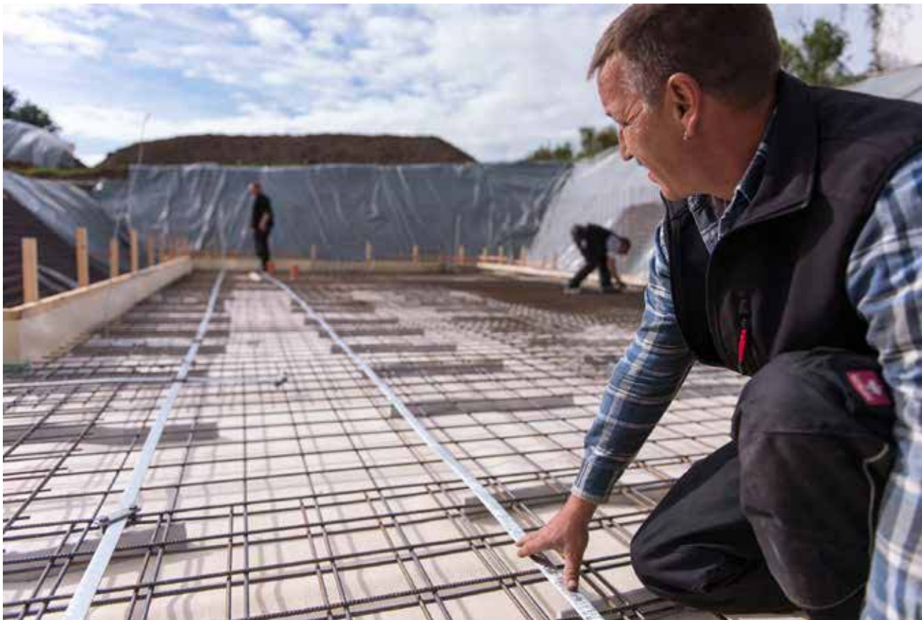
Рис. 2.75: Прокладка фундаментного заземлителя
