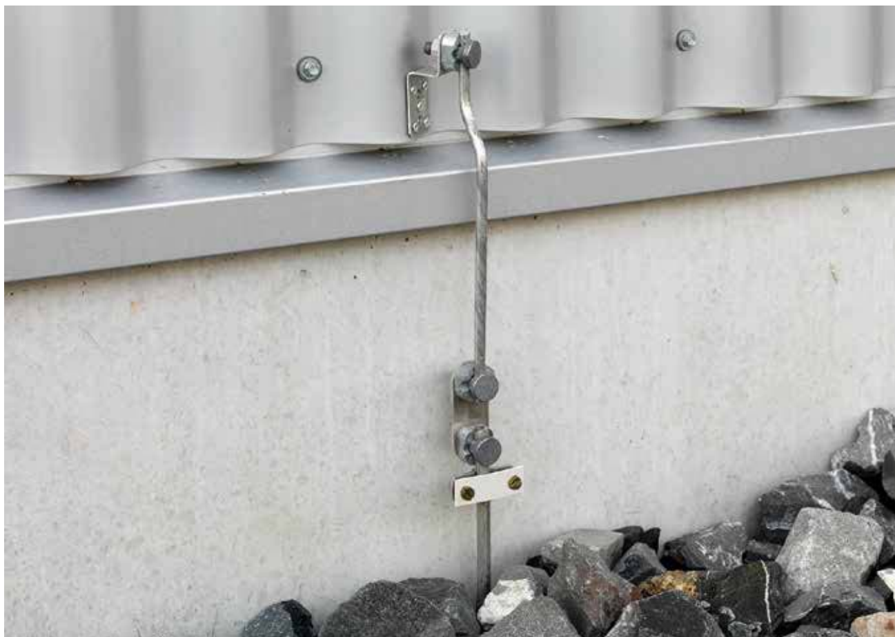
Рис. 4.1: Место разделения на металлическом фасаде
